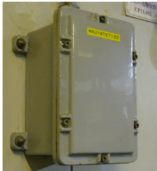
圖 6 未經檢定的防爆電氣機具
