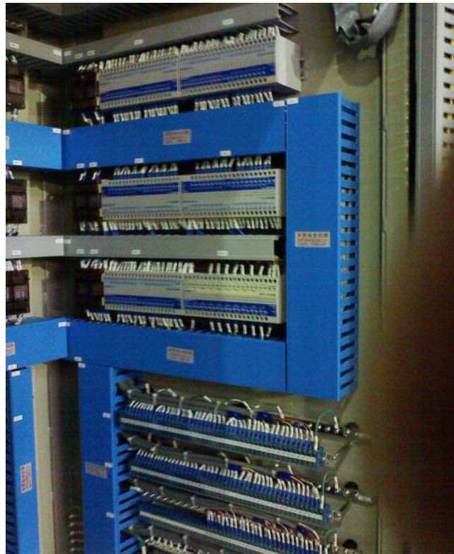
圖 3 控制箱內的本質安全防爆保持器
