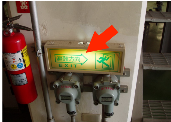
圖 5 防爆電氣機具與一般電氣機具並存
